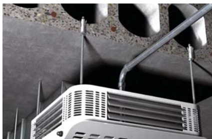
Vzduchotechnické jednotky montované k dutinovým panelům z předpjatého betonu
