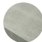
Plné vápenopískové zdivo
