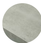
Plné vápenopískové zdivo
