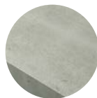
Plné vápenopískové zdivo
